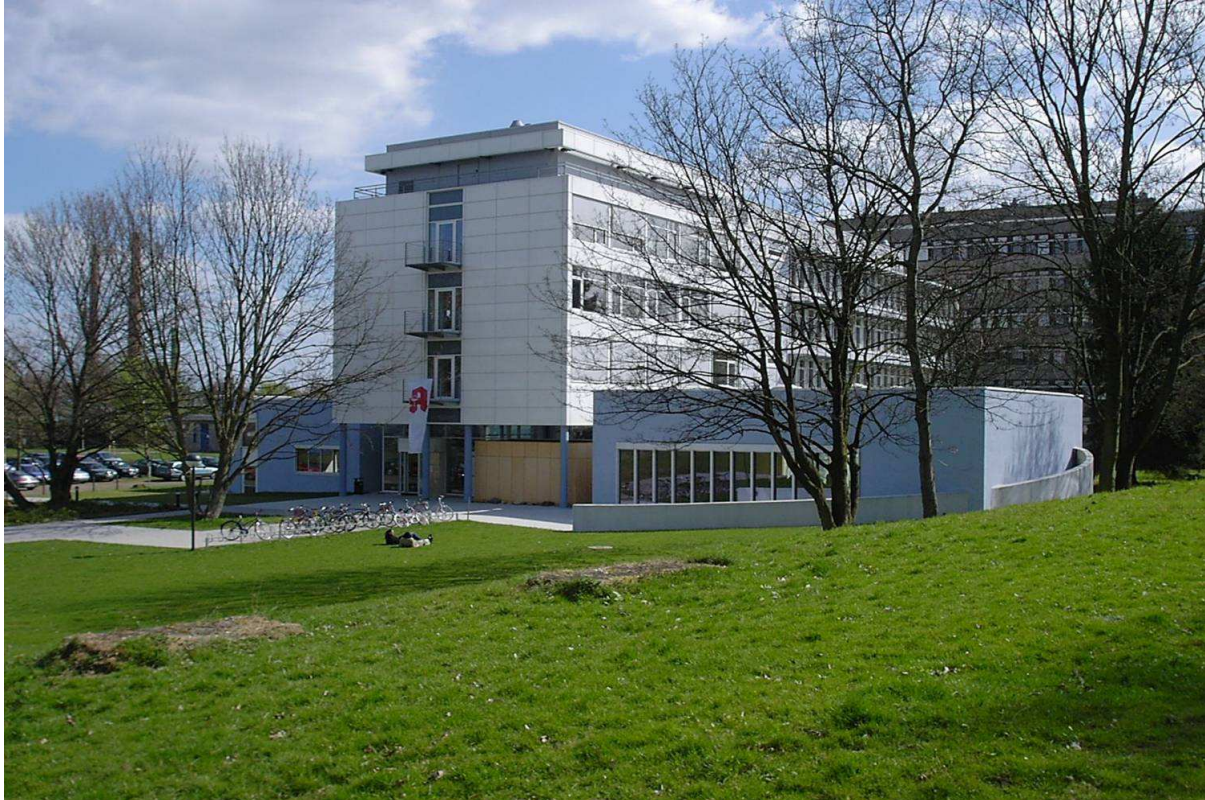
Neubau Gerhard-Domagk-Straße, eröffnet 2002
